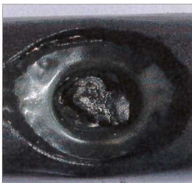
Bild 3. Fehlerstelle NA2XS(F)2Y 1x150 RM/25
