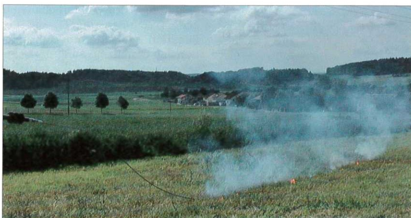
Bild 7. Seilabriss im Freileitungsnetz
